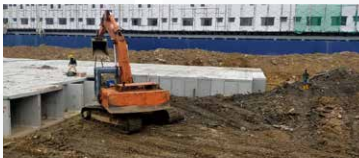
Keluasan kolam OSD dibahagikan kepada 2 iaitu OSD 1 (60x40x1.8m) di kawasan padang dan OSD 2 (6x170x3m) di kawasan letak kereta rumah pangsa.
