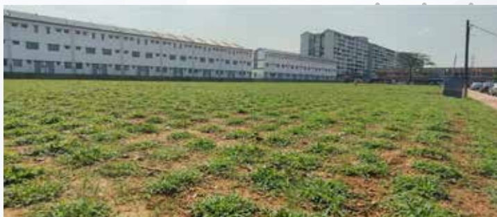
Keluasan kolam OSD (3,420m 2 ) dapat menyimpan air larian permukaan sebanyak 7,380m 3 dalam tempoh 1 jam sebelum ianya dilepaskan keluar ke Sungai Klang.
