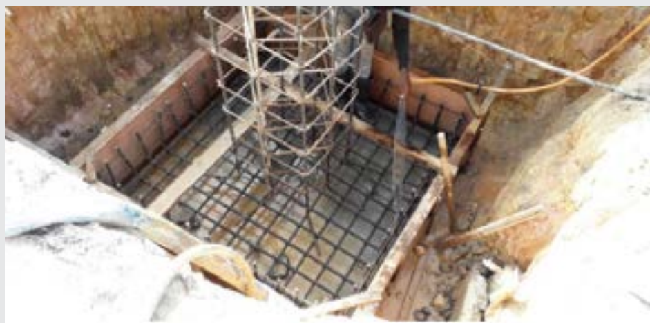
Gambarajah 1.2 Kerja-Kerja Formwork Sedang Dijalankan.
