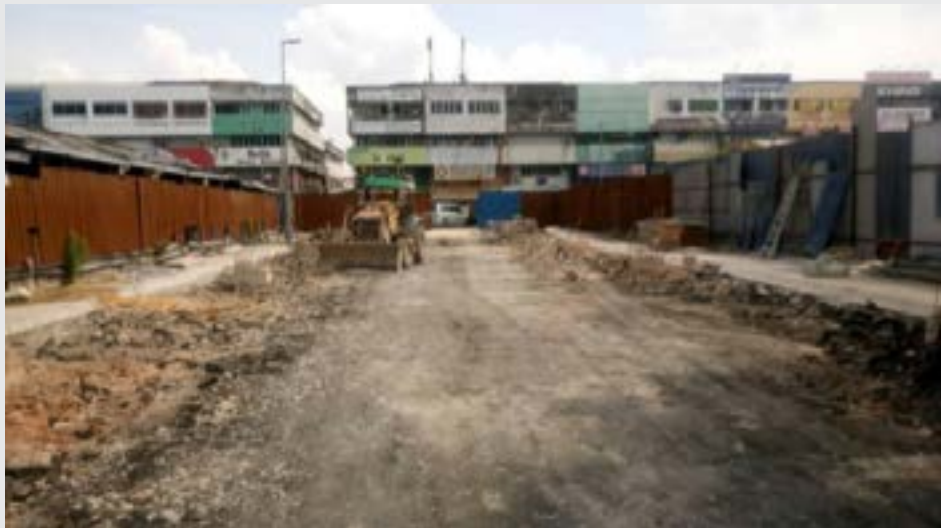
Gambarajah 1.1 Kerja-Kerja Pad Footing Sedang Dijalankan.
