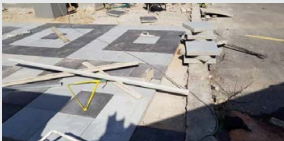
Gambarajah 1.2 Pemasangan Neupave Bagi Laluan Pejalan Kaki
