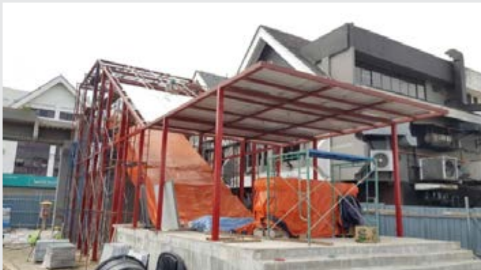
Gambarajah 1.1 Pemasangan Bumbung Bagi Kawasan Escalator
