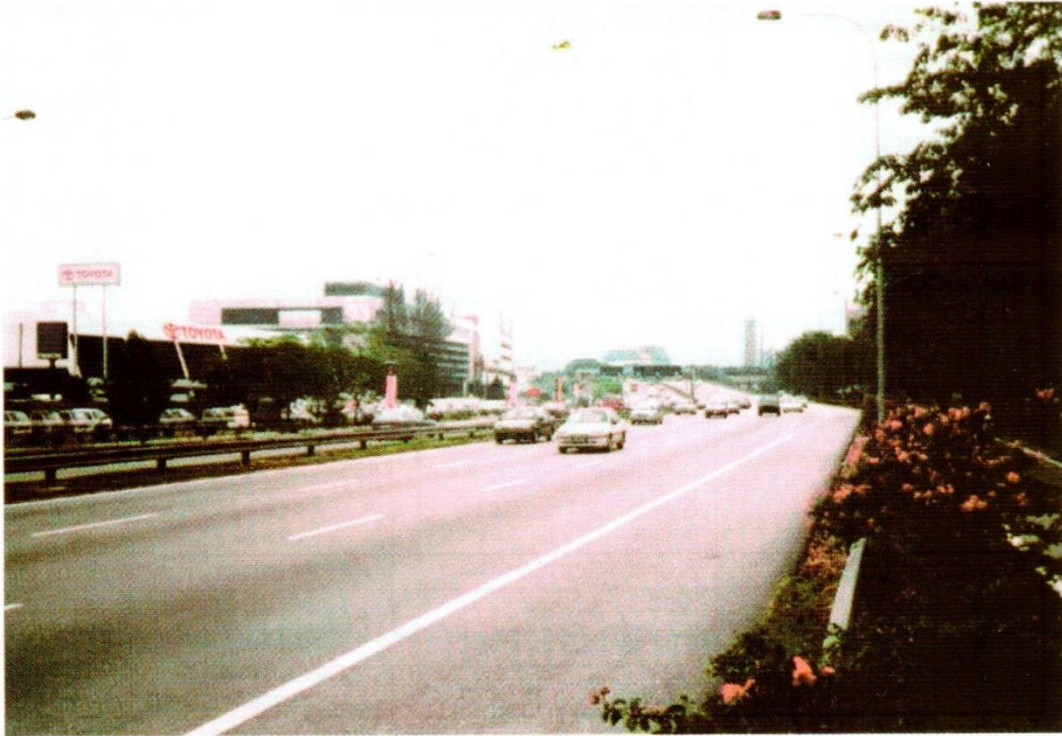
Gambarfoto 5.22 : Penanaman pokok di pinggir jalan amat kurang di sepanjang Lebuhraya Persekutuan 2
