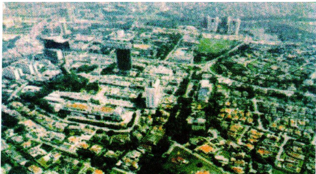
Gambarfoto 3:4: Pembangunan semasa di Pusat Bandar Seksyen 52
